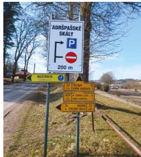
Čištění dopravního značení
