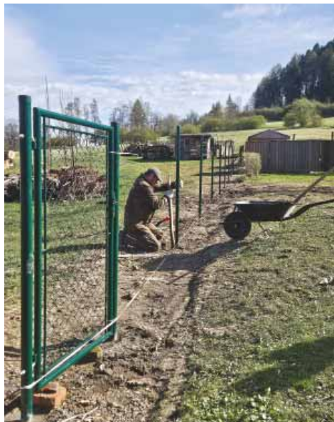
Instalace plotu č.p. 141
