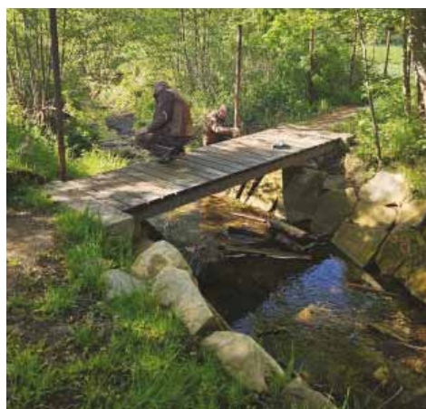
Oprava mostku D.A.
