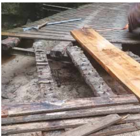
Výměna lávek ze Sloního nám. ke Kobercům
