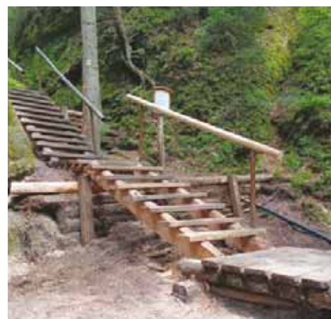
Výměna schodiště před Vlčí roklí
