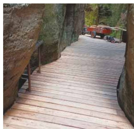
Výměna lávek ze Sloního nám. ke Kobercům
