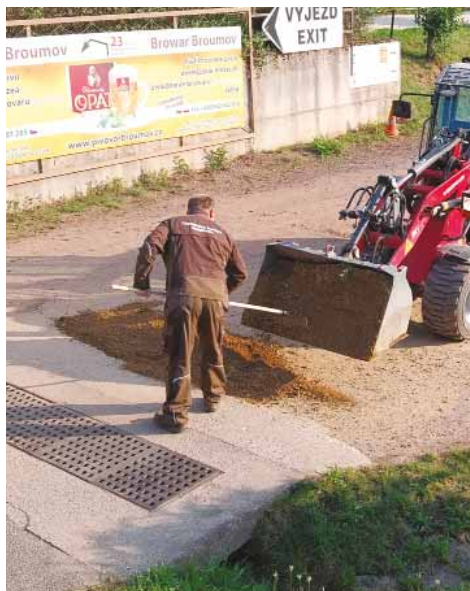
Oprava povrchu parkoviště
