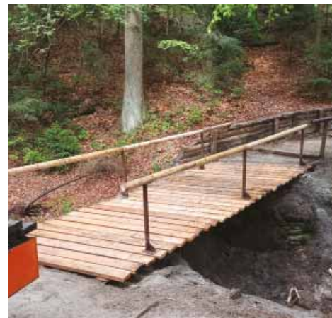
Výměna mostku u Malého vodopádu
