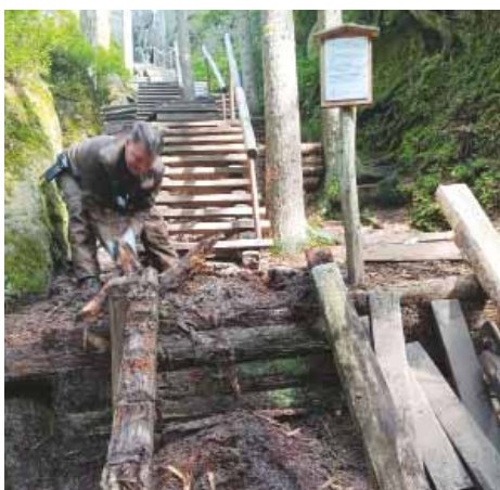
Výměna schodiště před Vlčí roklí
