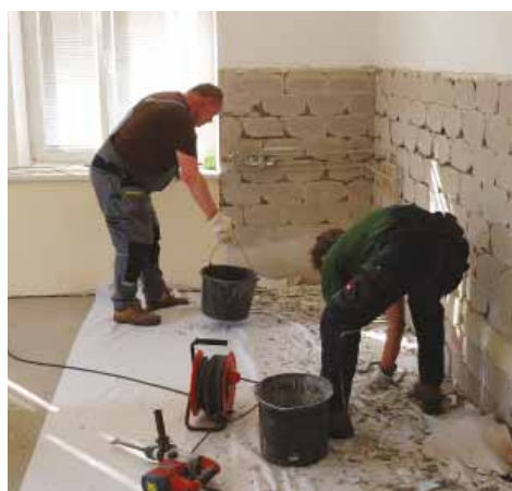
Příprava nové kuchyně ve školce
