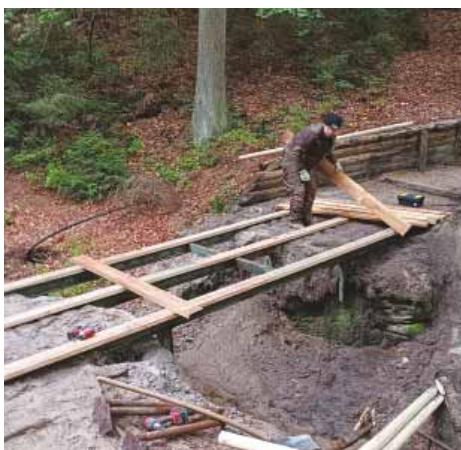
Výměna mostku u Malého vodopádu
