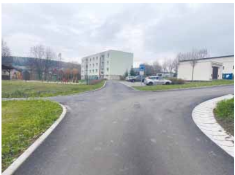
Obr. 2: Oprava cesty a zpevnění plochy před požární zbrojnicí
