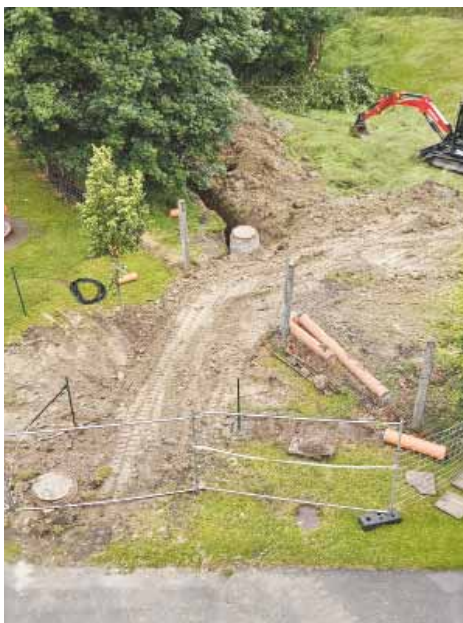
Obr. 3: Sanace kanalizace a přípojka
