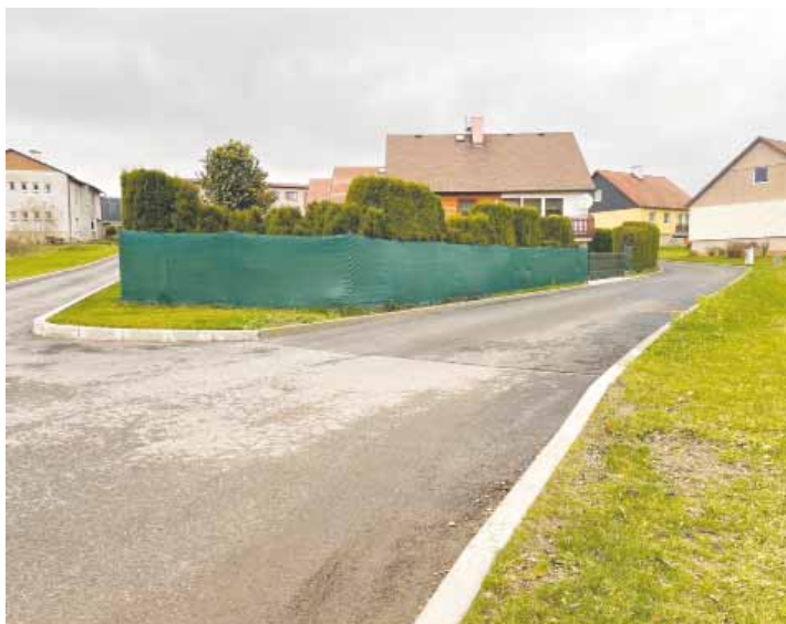
Obr. 4: Oprava komunikace kolem okálů
