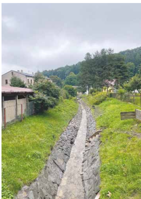
Obr. 6: Vyčištění a vyspárování potoka, vlevo stav před vyčištěním, vpravo stav aktuální
